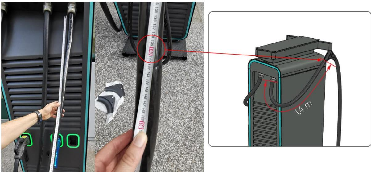
Abbildung 8: Positionierung der Kabelhalterung
